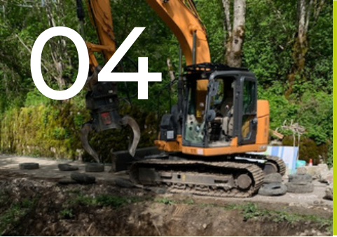
Travaux sur la commune
